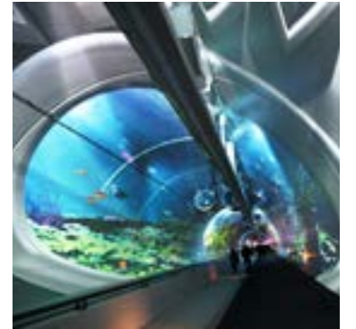
Tunnel de la Croix-Rousse à Lyon (69). L'ambiance, la ventilation et la surveillance de ce tunnel large de 10 m ont été conçues pour le confort des voyageurs en bus, des piétons et des cyclistes qui l'utilisent.
