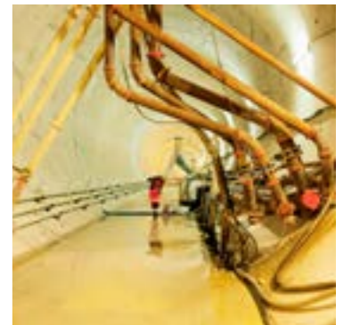
Prolongement de la ligne 12 du métro à Aubervilliers (93). Les équipes de VINCI Construction France, au sein d'un groupement, poursuivent les travaux en construisant les stations Aimé Césaire et Mairie d'Aubervilliers. Ce chantier accompagne le développement du Nord-Est parisien et désenclavera la commune d'Aubervilliers en la reliant à Paris par un mode de transport collectif performant.
