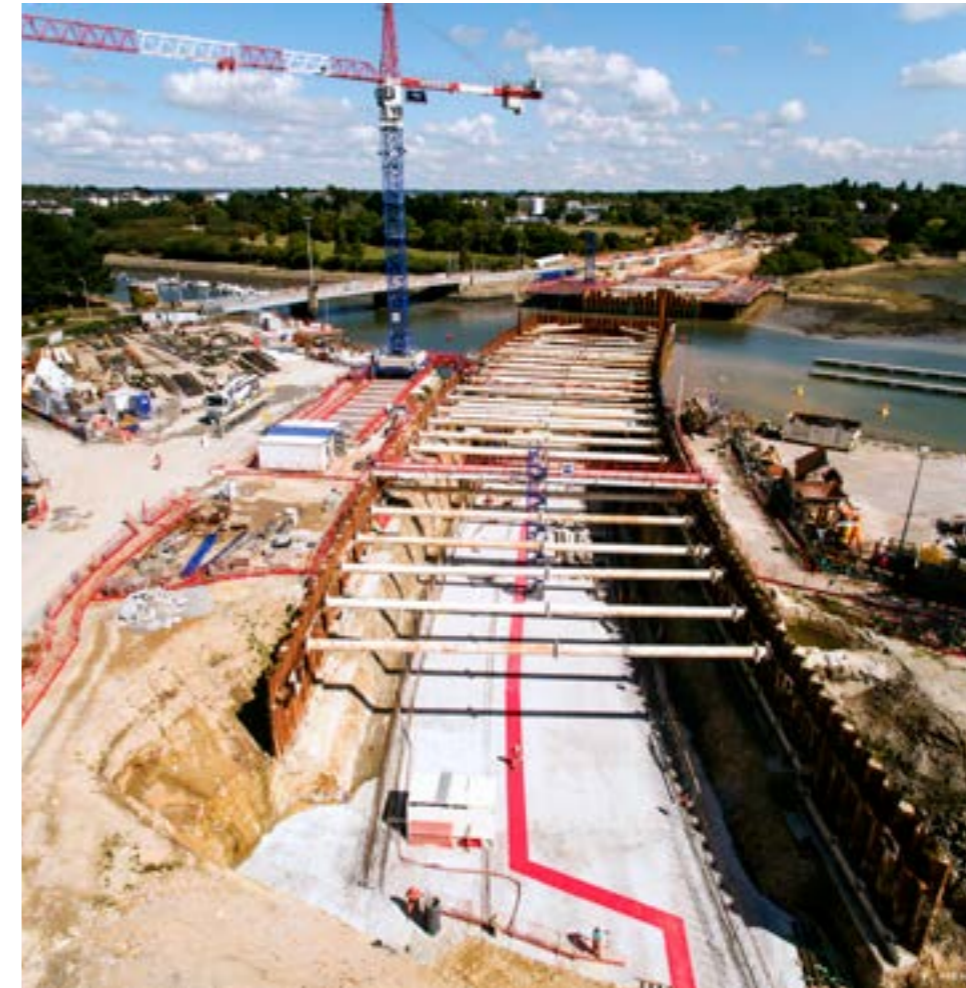
Comment réduire les embouteillages sur le pont de Kérino, qui laisse passer les bateaux de plaisance et permet aux véhicules de franchir le bras de mer situé à l'entrée du port de Vannes (56)? Pour répondre à cet enjeu, un partenariat public-privé (PPP) a été engagé pour la réalisation d'un passage inférieur. Sous le lit de la rivière, deux sens de circulation avec terre-plein central sont prévus ainsi qu'une voie de circulation douce, isolée physiquement, pour les piétons et les cycles. Le projet inclut la réalisation de 580 m de nouvelles voies, dont deux giratoires et 250 m en section couverte.
