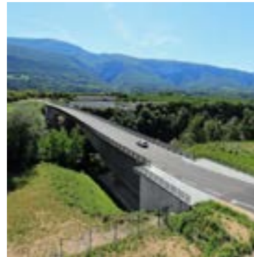
Au terme de vingt-huit mois de travaux, le nouveau pont d'Izeron (38) a été inauguré le 10 juillet 2015. Remplaçant un ancien pont suspendu sur l'Isère, très dégradé, cet ouvrage d'art de 258 m présente une travée centrale de 180 m composée de deux fléaux béton construits par encorbellements successifs et d'une ossature mixte cantilever (en porte-à-faux).
