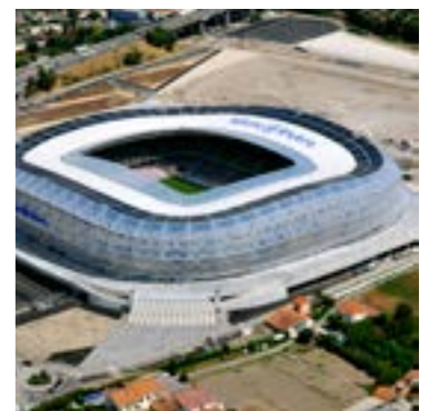
Stade Allianz Riviera à Nice (06). Construit et livré en un temps record, et premier ouvrage structurant du projet Éco-Vallée Plaine du Var, le stade Allianz Riviera est une réalisation d'une complexité inégalée.
