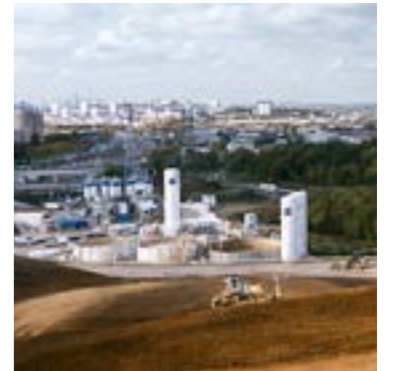
Le projet de déviation de la RN19 au niveau de Boissy-Saint-Léger (94) a été conçu pour désengorger la ville. Les équipes de VINCI Construction France ont mis au point un béton résistant au feu pour les parois moulées et la dalle de couverture. Gages du succès de l'opération : une offre de service globale, une solution innovante et la complémentarité d'un groupement 100 % VINCI.
